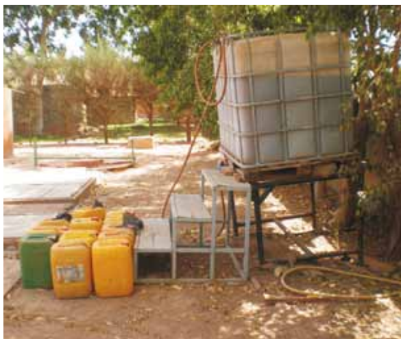
Gráfico 13: Almacenamiento de la orina en tanques de un metro cúbico Foto: Anna Richert
