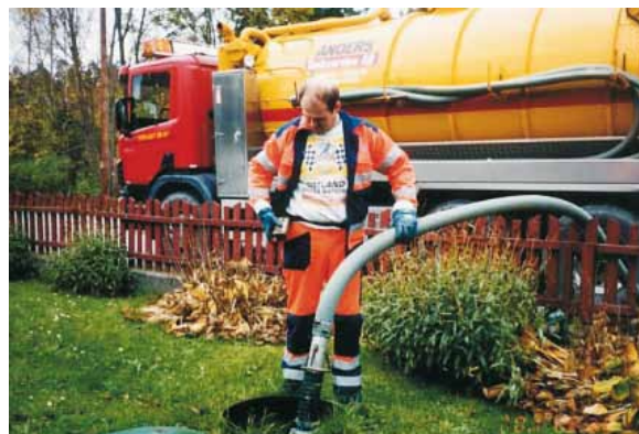
Gráfico 24: Un camión succionador convencional, recogiendo lodos de un sistema de aguas residuales in situ Foto: Municipio de Västerviks, Suecia
