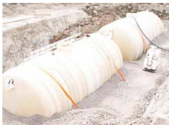
Gráfico 17: Tanques de almacenamiento durante la construcción del área de viviendas en Kullön, Suecia. Cada tanque tiene 12 m 3 Foto: Mats Johansson, VERNA
